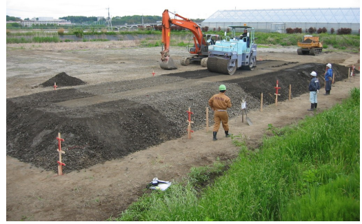
写真6 試験盛土作製状況
