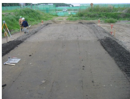
写真7 試験盛土表面状況 (手前：配合②、奥：配合③)
