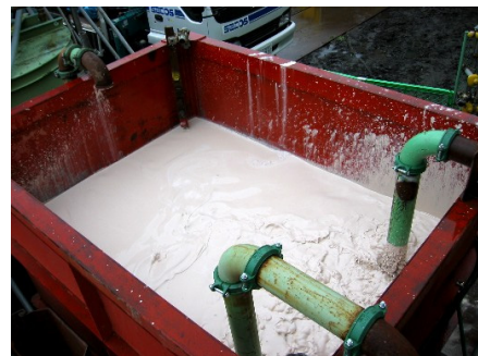
写真3 Mg系固化材スラリー作製状況
