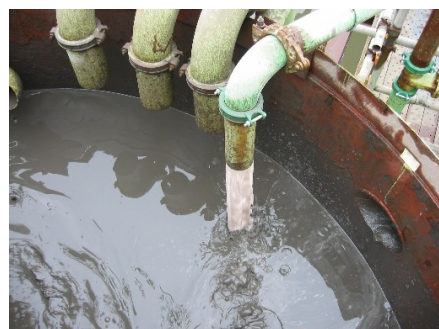
写真4 Mg系固化材スラリー添加状況
