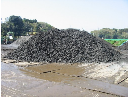
写真5 作製後脱水ケーキの仮置き状況
