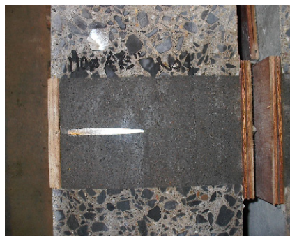
写真2 充填状況（工法②）
