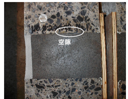
写真3 充填状況（工法③）
