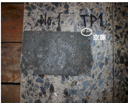
写真1 充填状況（工法①）
