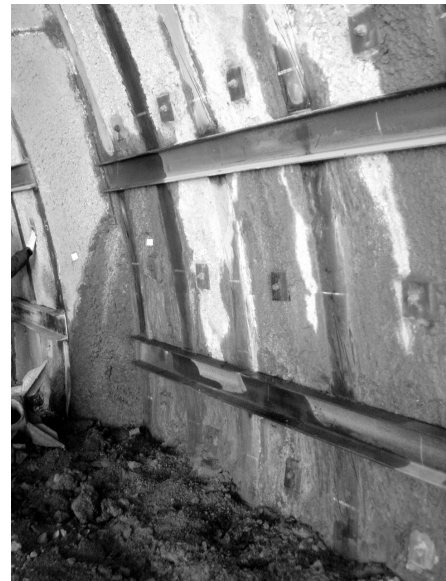
写真2 変状対策工 (増しボルト, 支保工連結)
