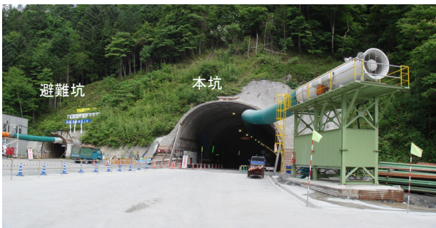
写真4 西側坑口全景
