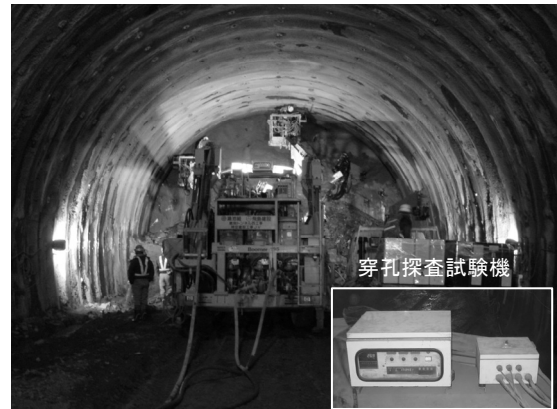
写真1 トンネル施工状況
