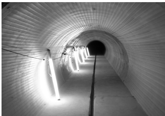
写真 4 FR 覆工完了
