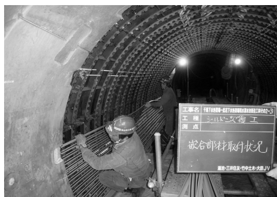
写真 3 FR 覆工施工状況
