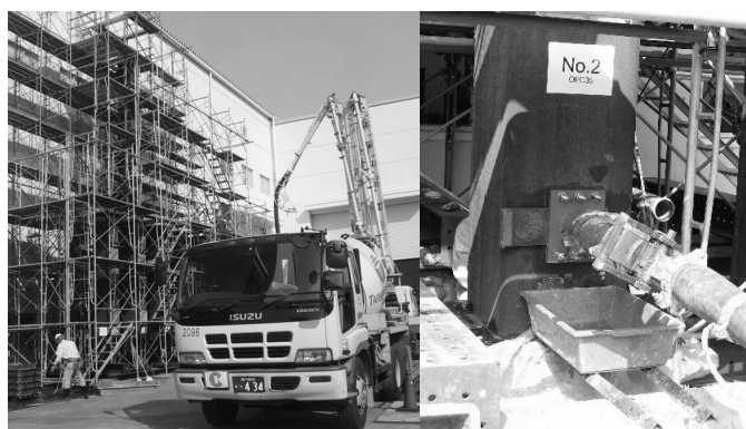
写真2 実大施工実験状況
