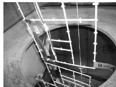
写真 3 柱内吊込み状
