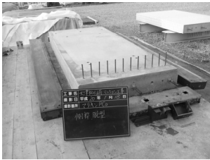
写真10 側枠解体
