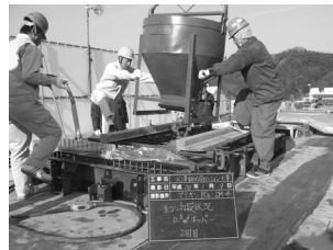
写真7 コンクリート打設
