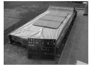
写真9 簡易加熱養生
