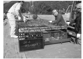
写真5 鉄筋組み込み
