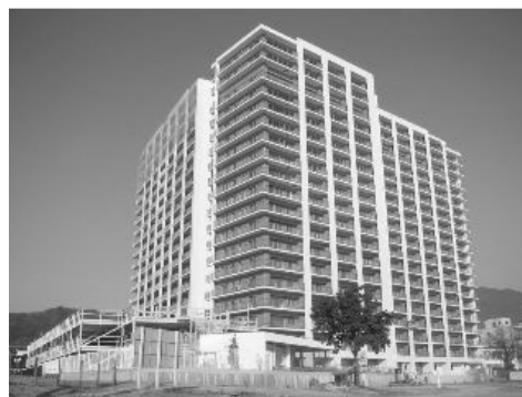
写真 1 建物外観(南東面)
