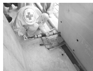
写真20 グラウト注入
