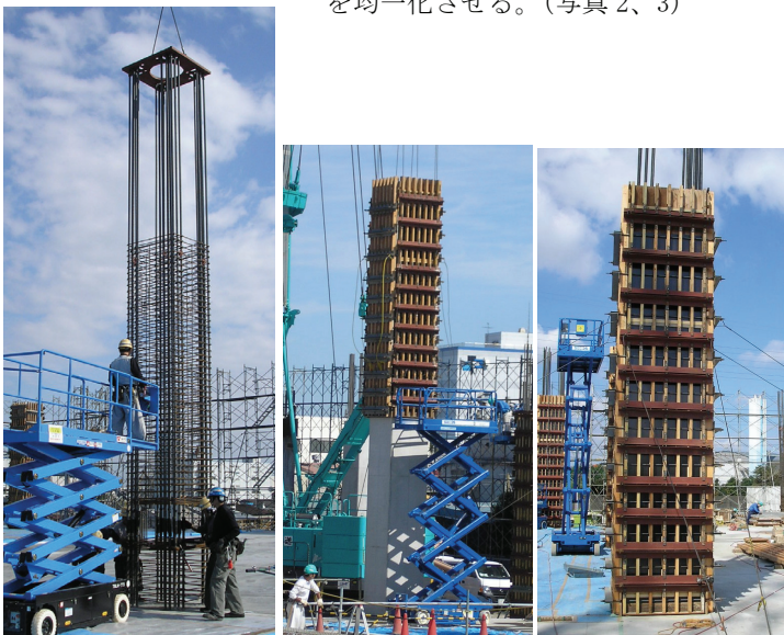
写真1 柱筋セット 写真2 柱型枠セット 写真3 柱型枠脱型
