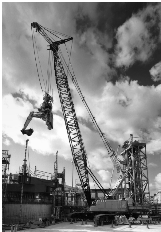
写真6 水中掘削支援機
