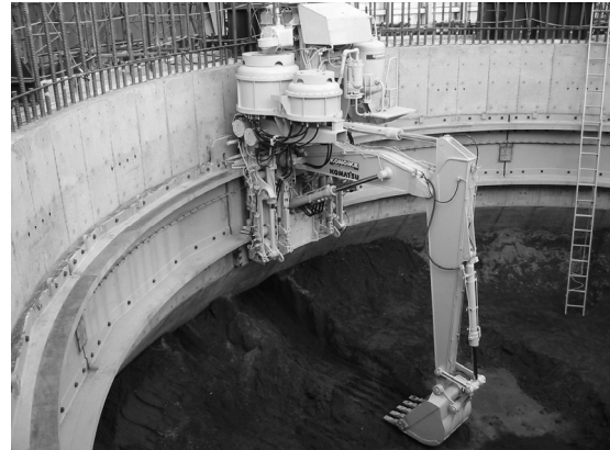
写真1 自動水中掘削機
