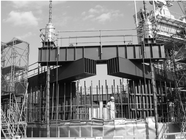
写真8 圧入桁の施工事例
