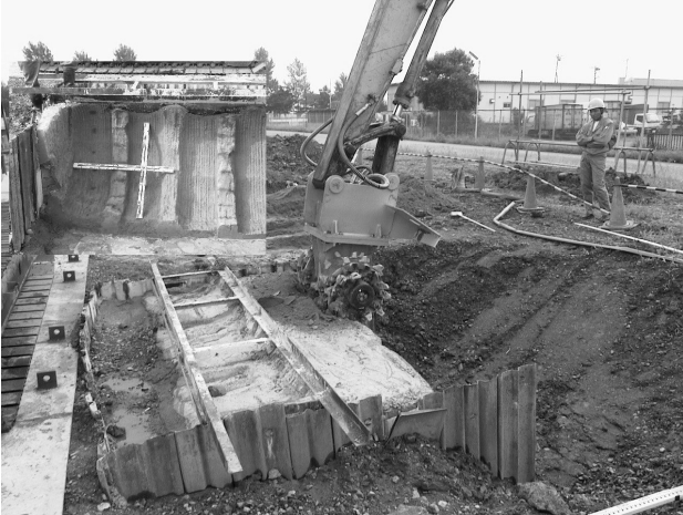
写真 11 ツインヘッダー掘削実証実験
