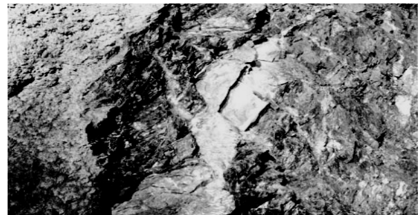
図7 側壁観察に観察された砂岩層の破砕構造
