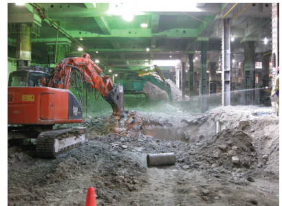
写真14 地下掘削・解体状況②
