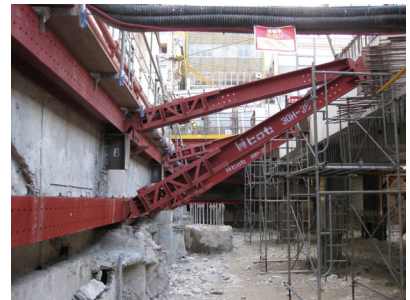
写真11 既存外壁と鋼製斜梁①
