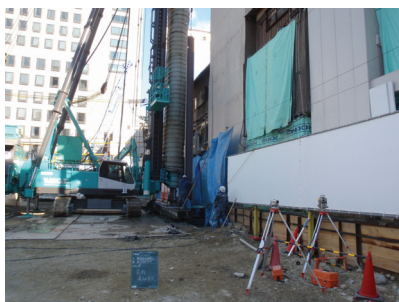
写真2 SMW 施工状況
