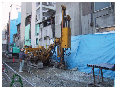
写真3 薬注・削孔状況
