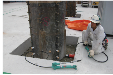
写真9 構真柱の水平位置修正状況
