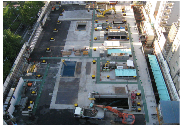
写真10 トップスラブ全景
