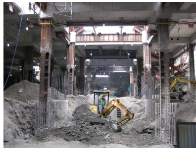
写真13 地下掘削・解体状況①
