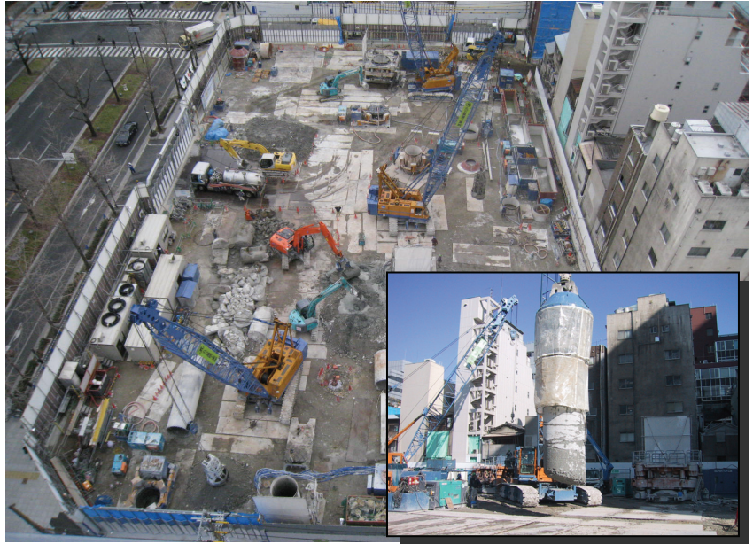
写真5 全周回転掘削(全景及び削孔状況)
