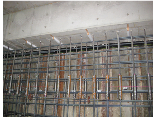
写真15 壁上部注入用スチロール
