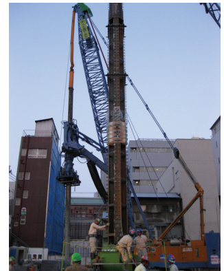
写真8 構真柱建て込み状況
