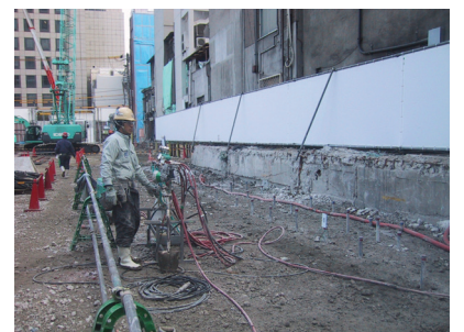
写真4 薬注・2次注入施工状況
