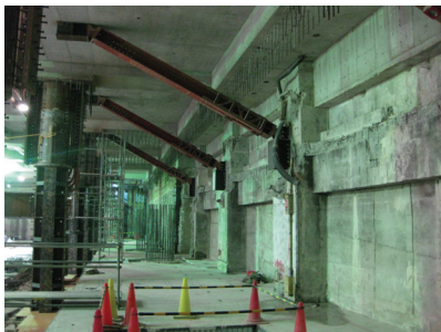
写真12 既存外壁と鋼製斜梁②
