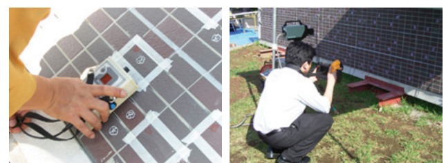
(3) 剥離検知器検査
