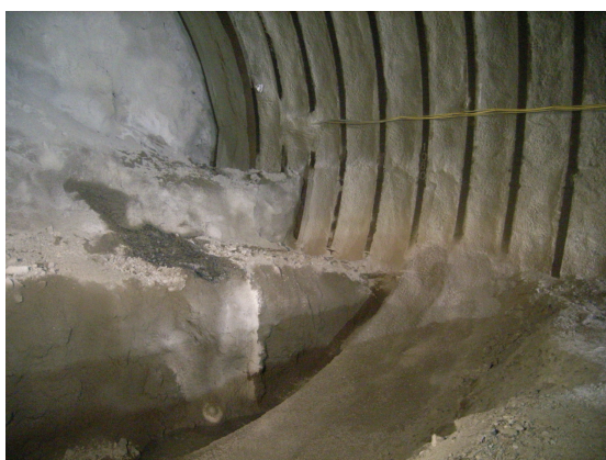
写真2 変位制御型二重支保の施工状況 8)
