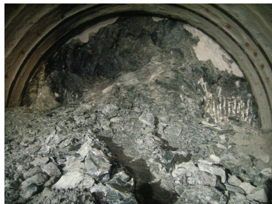
写真4 蛇紋岩切羽状況
