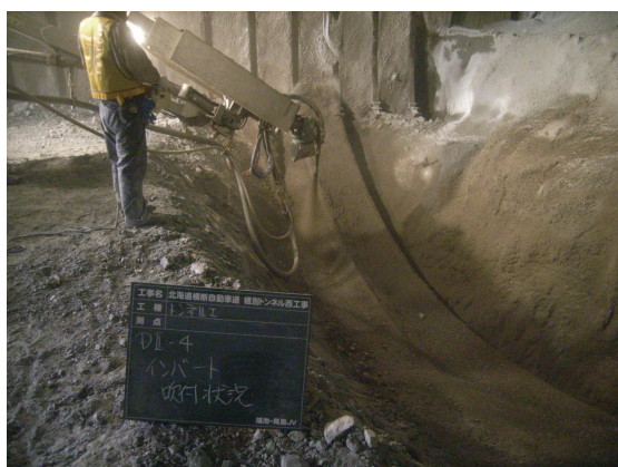
写真3 インバート同時施工状況 8)
