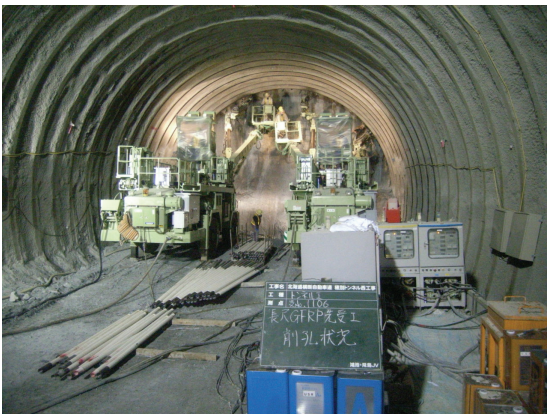
写真5 補助工法施工状況 6)
