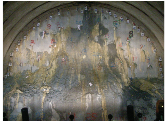
写真6 補助工法施工完了状況 6)
