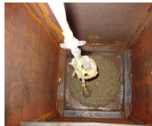
写真23 圧入充填状況
