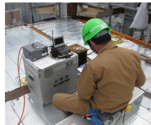
写真21 柱頭計測器設置
