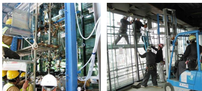
写真 29 実大性能試験
