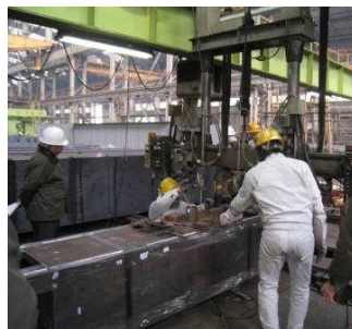
写真4 試験体製作確認
