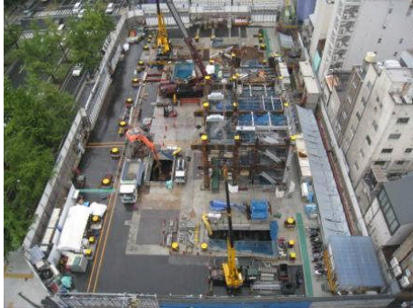
写真8 1節鉄骨建方
