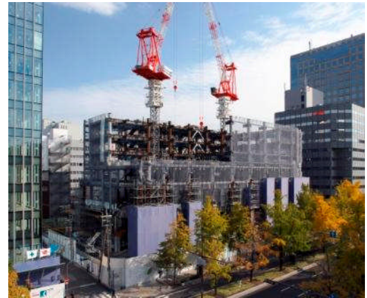
写真11 3節(基準階)鉄骨建方
