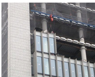
写真 28 外部取り付け
