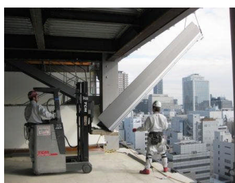
写真 27 外部取り付け
