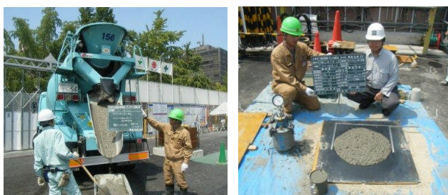
写真16 実機による経時変化の確認状況
