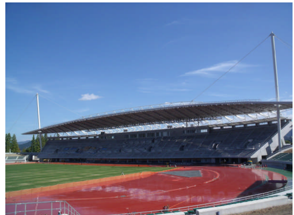
写真1 スタジアム外観
