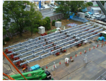
写真2 屋根大梁地組1
