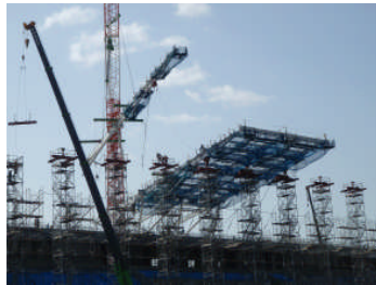
写真4 屋根大梁設置
