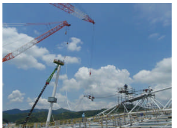
写真10 マストケーブル設置
