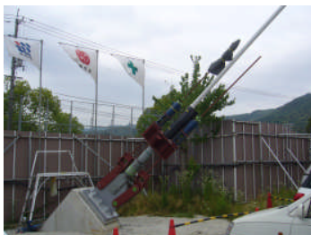
写真9 マストケーブル接合部
