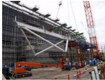
写真3 屋根大梁地組2
