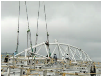
写真6 キールトラス設置
