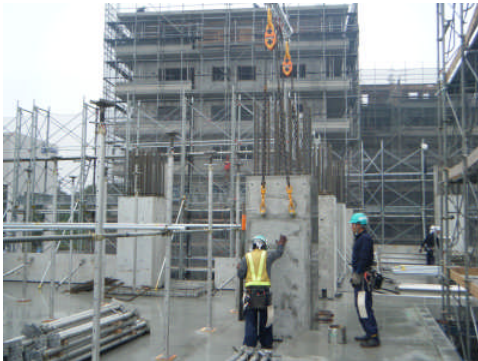
写真3 柱 PCa 建方
