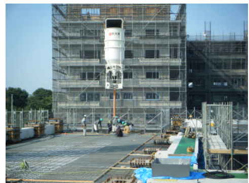
写真7 コンクリート打設
