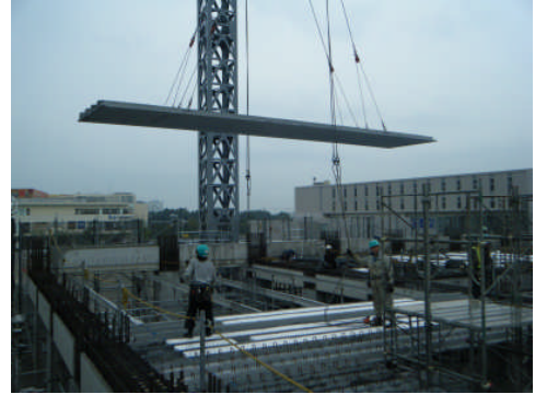
写真5 内床 PCa 板建方
