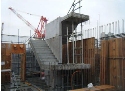
写真 8 階段 PCa 建方
