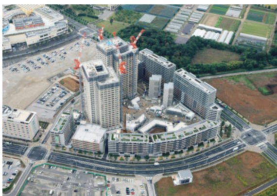
写真1 施工中の建物全景
