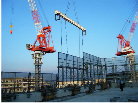
写真2 ユニット足場クライミング
