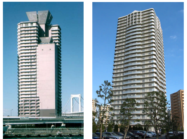
(a) 観測建物1 (b) 観測建物2 写真2 建物外観
