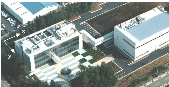
写真 1 観測建物 左:管理研究棟(免震) 右:実験棟(非免震)
