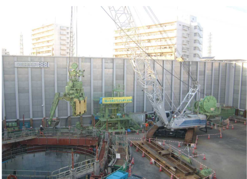
写真 2 水中掘削支援機
