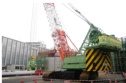
写真 3 電動油圧グラブ仕様の掘削揚土クレーン
