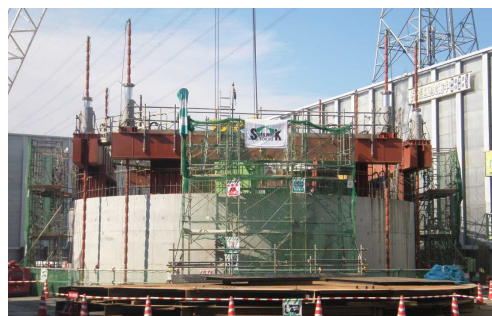
写真 5 圧入設備の施工事例
