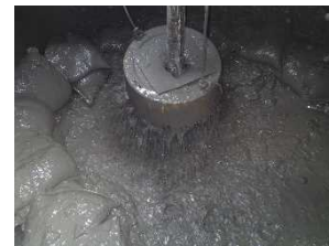
写真2 排泥状況 (両発進立坑の盤ぶくれ対策工)
