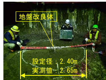
写真 3 地盤改良体の改良径測定状況（床付け時）
