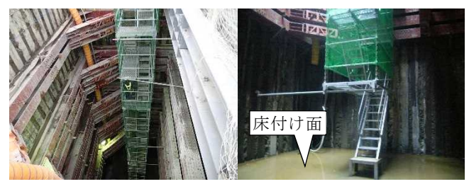
写真1 掘削完了状況 (両発進立坑)
