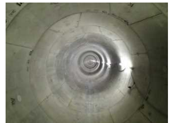
写真 5 雨水拡充管完成状況
