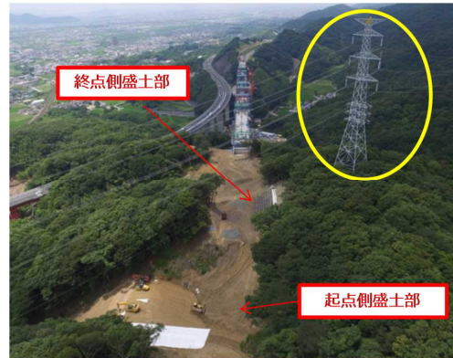
写真4 鉄塔・送電線の状況（盛土部付近）
