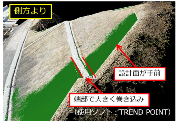
図21 異常値検出の原因(端部ラウンディング部)
