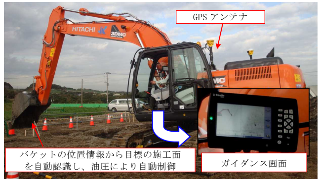
写真2 ICT 建機による施工状況
