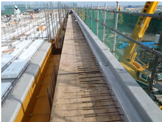
写真 12 先端 PCa 設置状況
