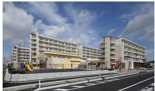
写真 13 桜木住宅完成状況
