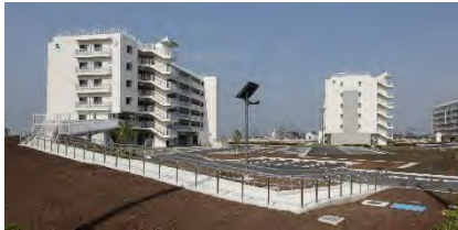
写真7 避難スロープ(D棟)
