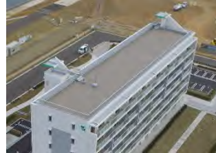
写真4 屋上避難場所（E棟）
