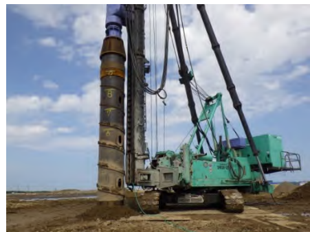
写真9 ケーシングを使用した掘削状況
