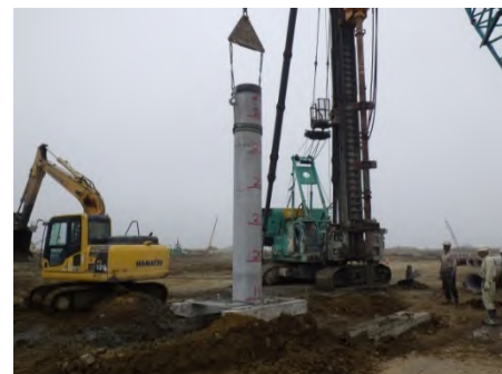
写真10 置き換え完了後のPHC杭建込状況
