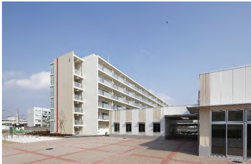
写真15 鶴ヶ谷住宅完成状況
