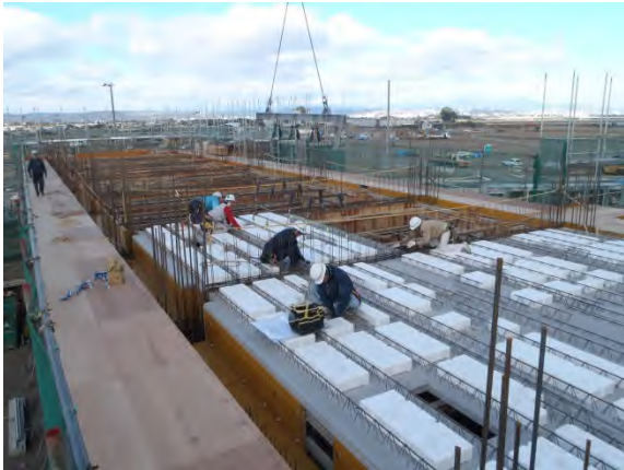
写真 11 ハーフボイド PCa 版設置状況
