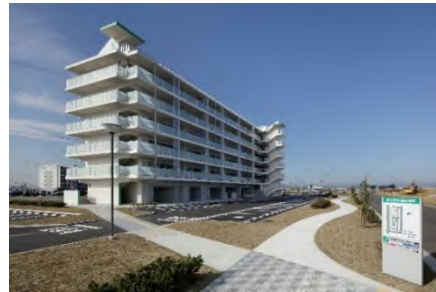
写真3 避難階段と誘導サイン（E棟）
