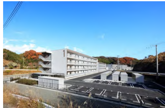
写真17 泉町本谷地区第1住宅完成状況
