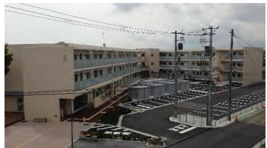
写真 14 新田住宅完成状況
