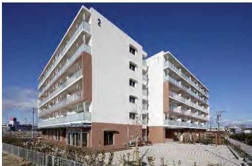
写真16 宮内住宅完成状況
