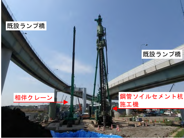
写真1 鋼管ソイルセメント杭の施工状況
