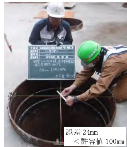
写真2 杭偏芯測定状況
