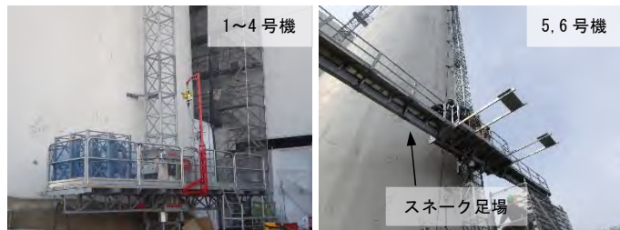
写真10 移動式昇降足場およびスネーク足場外観
