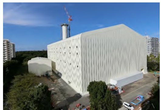
写真 4 工場棟全覆い仮設テント全景
