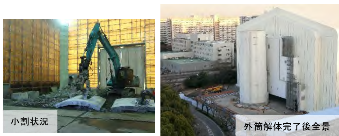
写真 12 切断ピース小割状況 写真 13 外筒解体完了後全景
