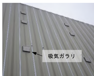
写真6 ガラリ設置状況
