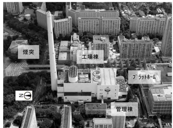
写真 1 解体工事対象施設
