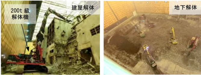
写真8 工場棟建屋解体状況 写真9 工場棟地下解体状況
