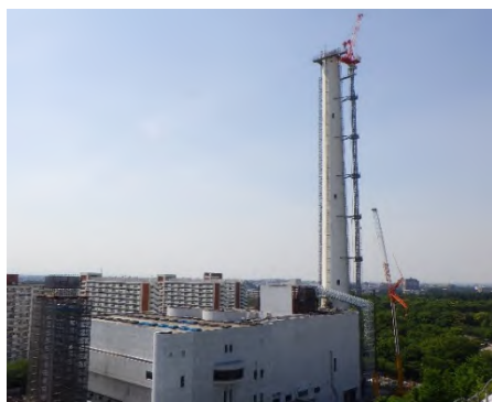
写真11 タワークレーン組立完了後の煙突全景
