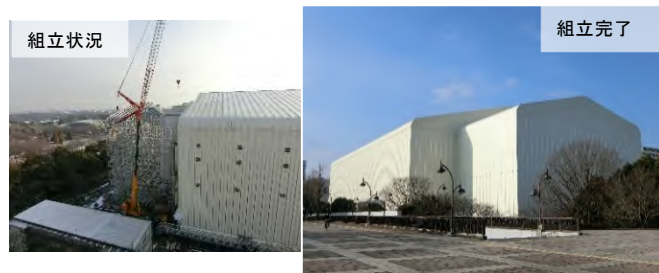
写真 14 煙突部テント組立状況および設置完了
