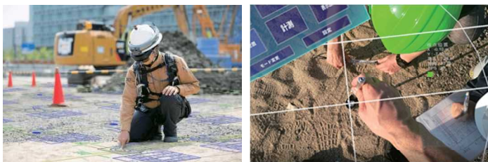
写真 16 杭芯確認検証 実施状況
