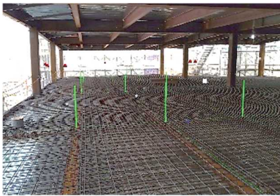
写真 15 マーカー設置状況
