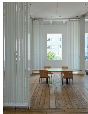
写真2 除湿型輻射パネル 設置例 6)
