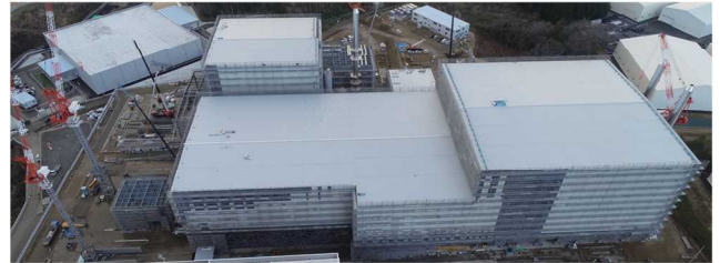
写真12 スライド全景写真
