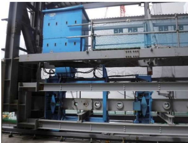
写真6 油圧ジャッキ建屋内設置状況
