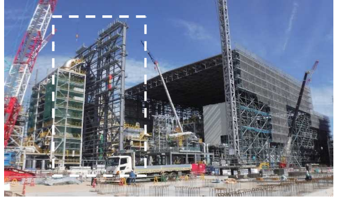
写真3 耐力壁の先行設置状況
