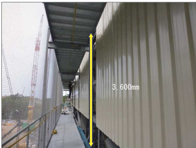
写真10 歩廊上での外壁施工状況
