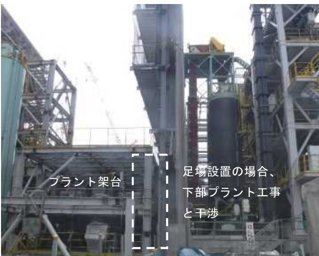
写真11 内部耐力壁歩廊鉄骨設置状況
