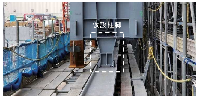
写真7 柱脚部（スライド時）
