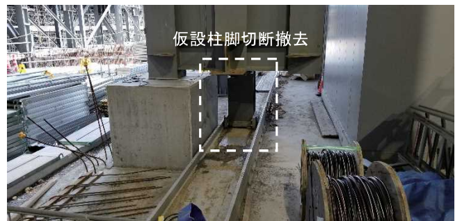
写真8 柱脚部（スライド完了時）
