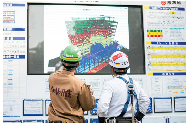
図14 BIMによる鉄骨モデル
