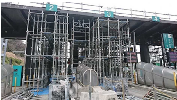
写真3 PC上屋支持用支保工設置状況
