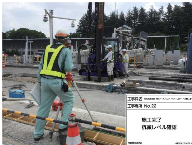
写真12 杭頭レベル確認状況
