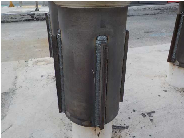
写真 16 既製鋼管杭と鉄骨の接合状況
