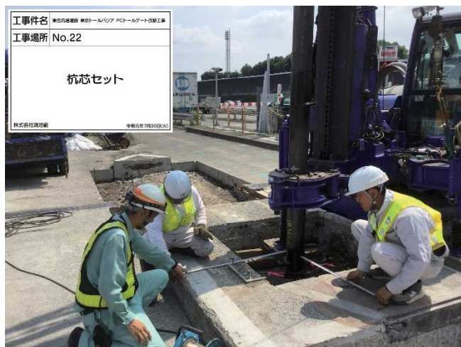
写真11 杭芯セット状況
