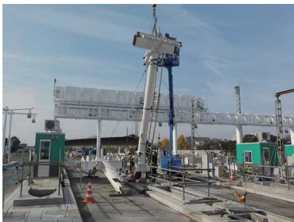
写真14 鉄骨柱建方状況
