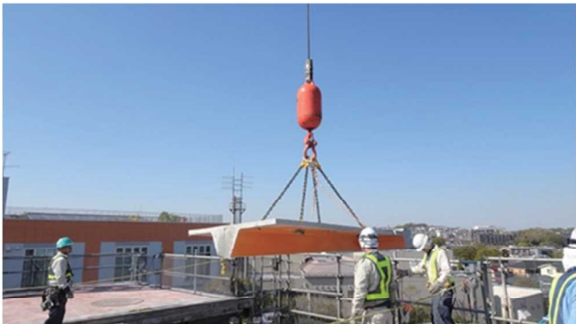
写真6 PC 上屋切断ピースの揚重状況
