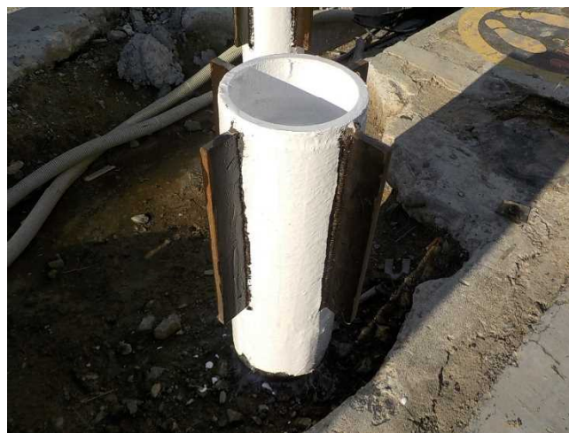
写真13 羽根付き鋼管杭の杭頭状況
