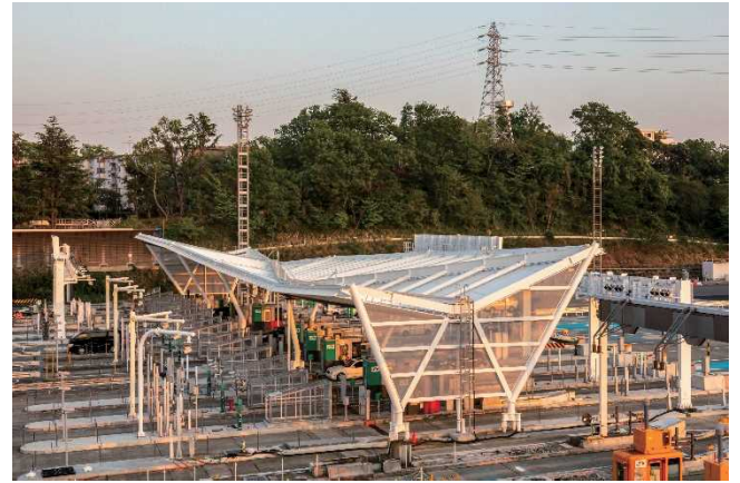
写真 17 完成した新設トールゲート①
