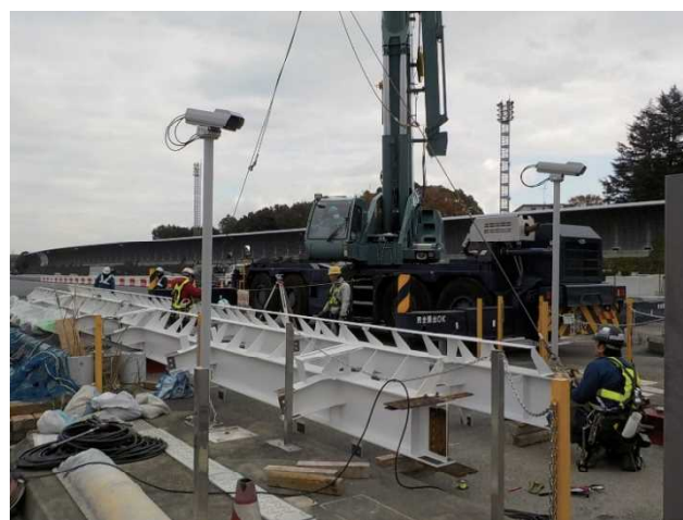
写真15 鉄骨大梁地組状況
