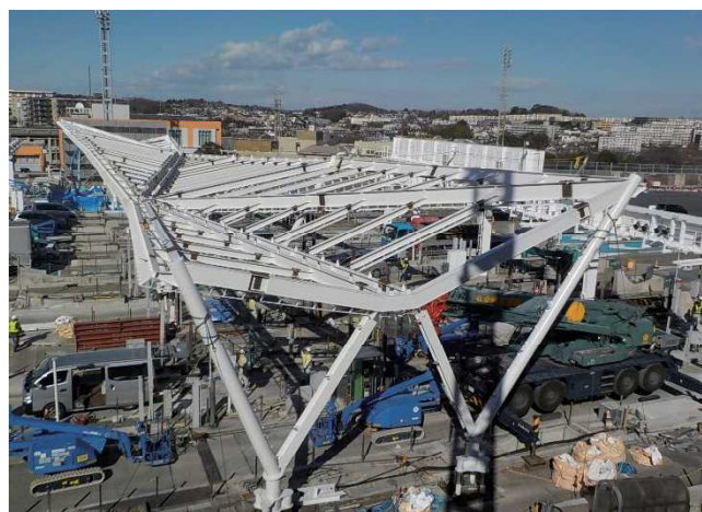
写真9 新設トールゲート鉄骨①
