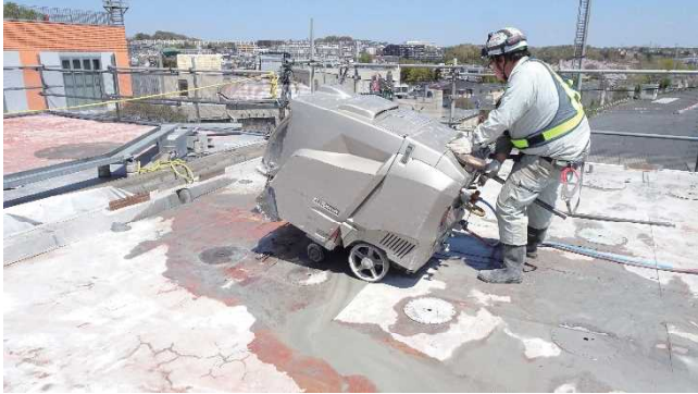
写真5 道路カッターによる上屋切断状況
