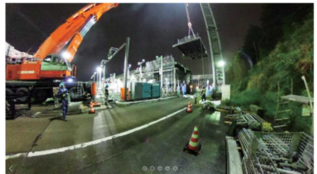
写真7 クレーンによる上屋の吊り切り揚重施工状況
