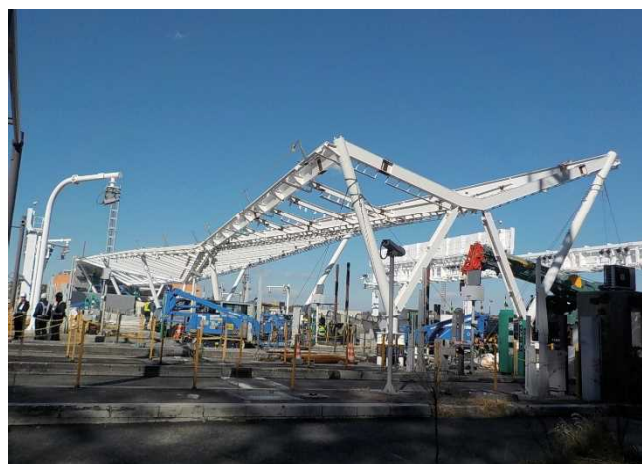
写真10 新設トールゲート鉄骨②
