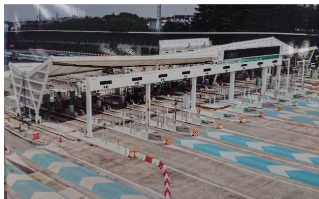
写真 1 完成した新東京トールゲート
