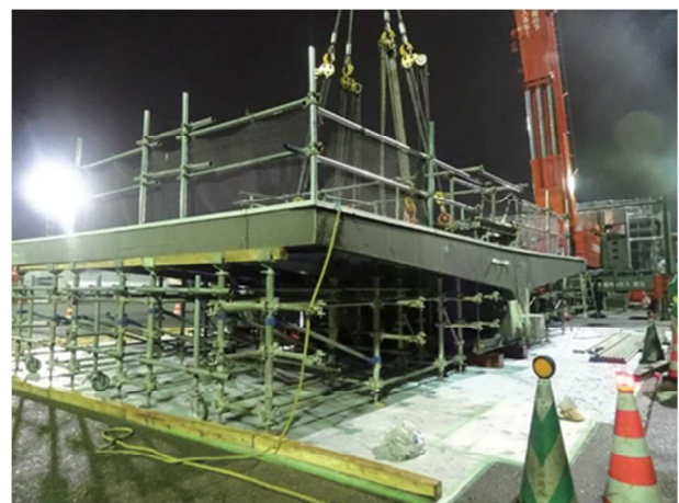
写真8 解体した PC 部材の仮置き状況
