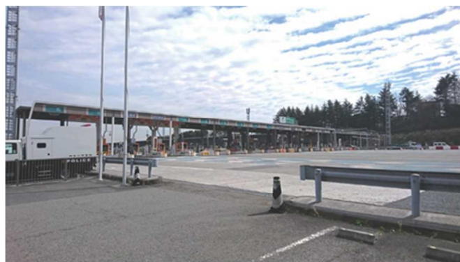
写真 2 解体前の東京トールゲート
