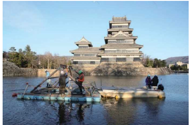
写真4 ピアフロート台船を併用した浚渫の状況
