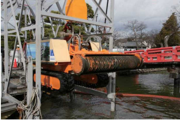
写真2 水中排砂ロボットと吊込架構
