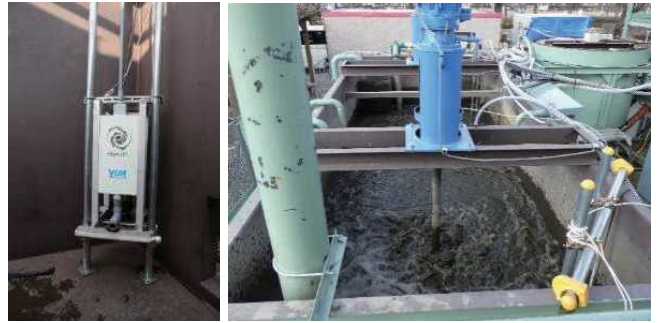
写真 7 原水槽内の UFB 発生装置の設置と稼働状況（オゾンを含む酸素 UFB + 鉄系凝集剤添加 + 弱酸性管理）
