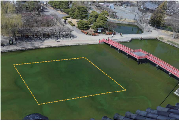
写真1 浚渫前の内堀（浚渫範囲 304m 2 、16m×19m）
