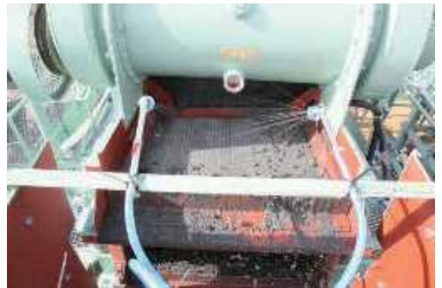
写真 9 一次処理土への酸素 UFB 水のシャワーリング
