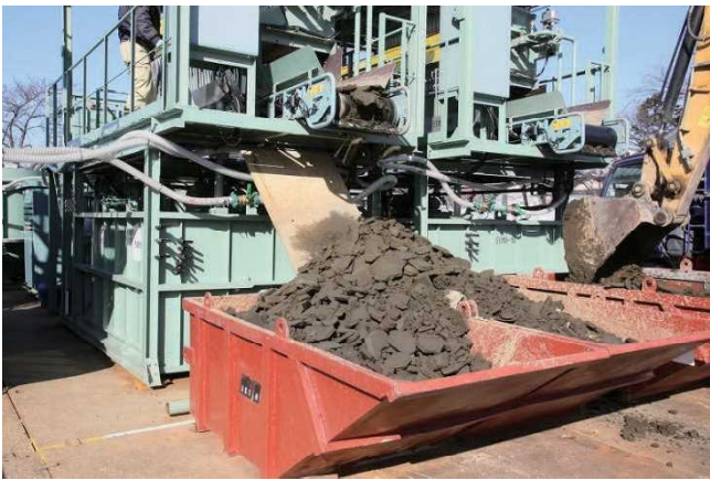
写真 11 脱水固化処理土（脱水ケーキ）排出状況
