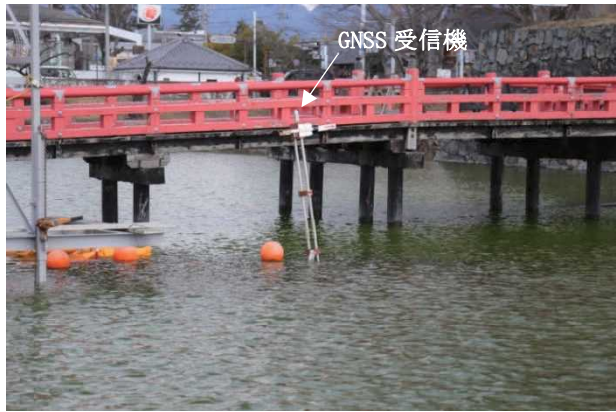
写真3 水中排砂ロボットの位置測量（GNSS測量）
