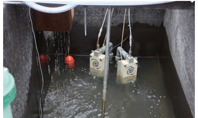
写真 8 放流水槽内の小型 UFB 発生装置（酸素 UFB）
