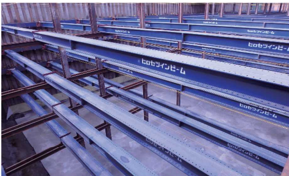
写真3 高強度支保工材の架設状況
