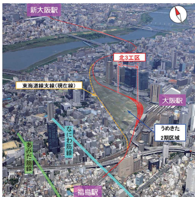
図1 工事場所（北3工区）
