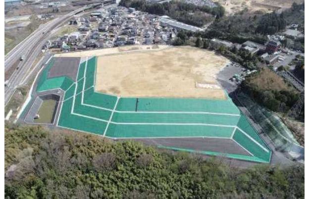
写真 20 完了時現場全景 (2021.3 撮影)
