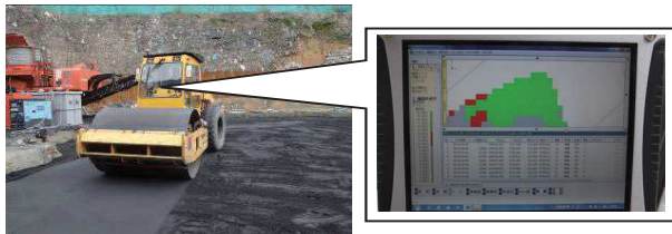
写真14 加速度センサ搭載型GPSローラー
