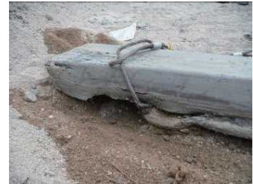
写真9 鋼矢板破損状況
