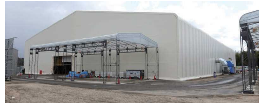
写真15 大型仮設テント
