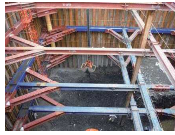
写真12 高強度切梁専用材および高強度腹起材の採用
