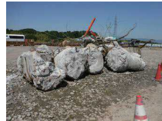
写真11 撤去コンクリートがら
