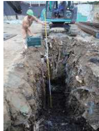
写真8 バックホウによる支障物撤去状況
