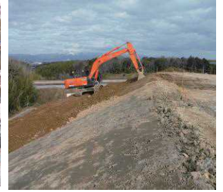
写真13 MGバックホウによる法面整形
