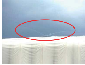
写真 17 スプリンクラー
