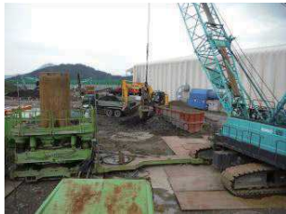
写真10 全旋回掘削機による支障物撤去状況
