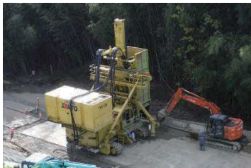
写真2 鉛直遮水工 (TRD 工法)
