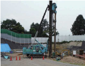
写真7 鋼矢板打設状況
