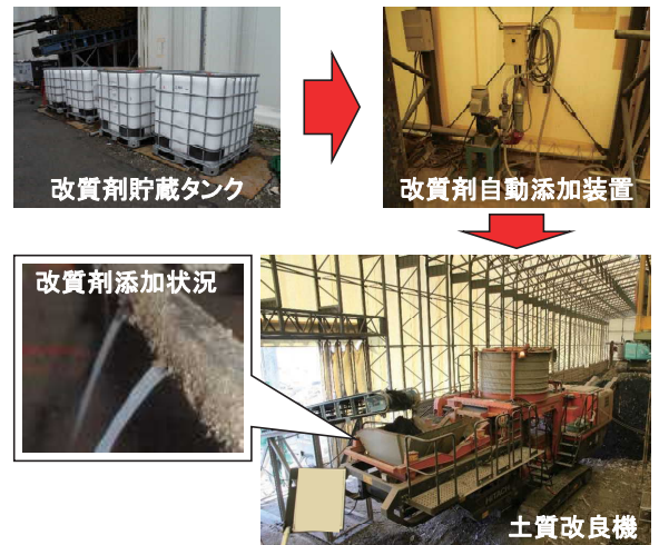
写真5 CWL1 自動添加、改良状況
