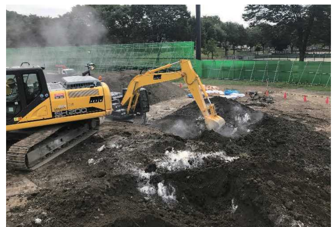
写真7 堆積土砂の改質状況(生石灰を添加・混合)
