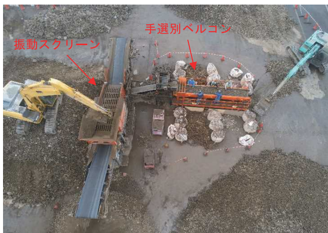
写真8 堆積土砂の選別状況
