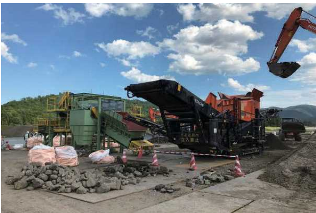
写真2 がれき混じり土砂の選別状況（振動スクリーン）
