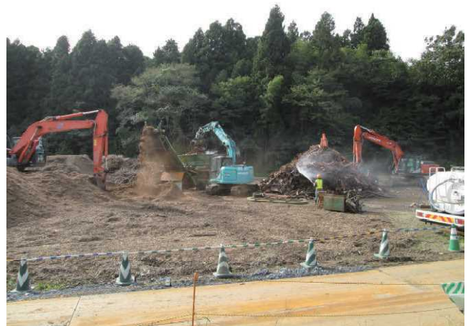
写真4 梨ヶ入流木仮置場
