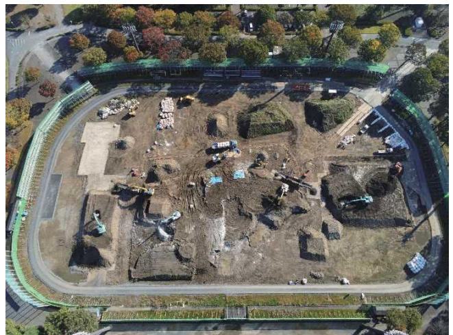
写真6 分別場(田沼グリーンスポーツセンター)
