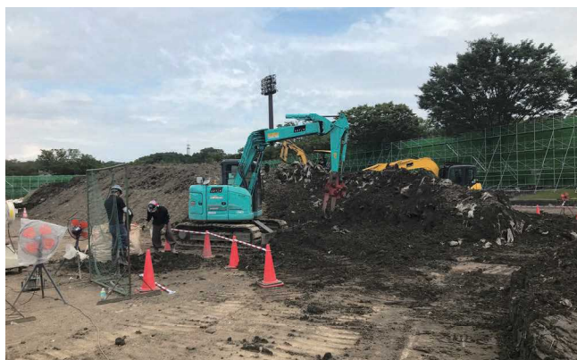
写真9 土砂を土のう袋から取り出している状況
