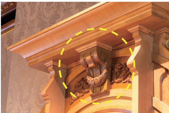
写真 28 3Dプリンター出力部分例（円内部分）
