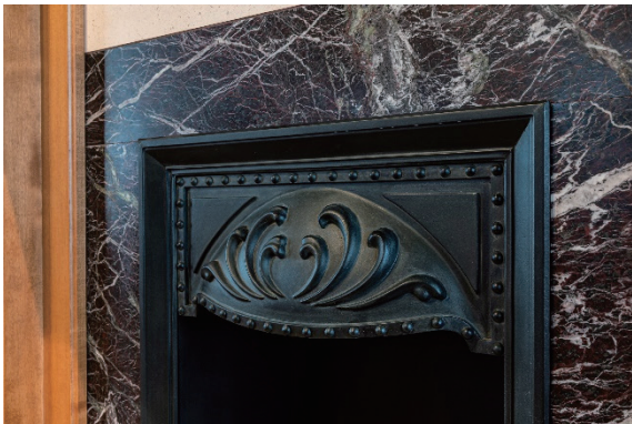
写真 34 暖炉部分再現完了状況
