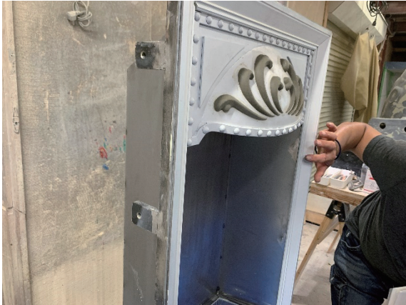
写真 33 暖炉部分製作状況
