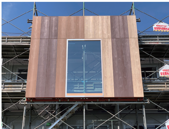
写真3 現場モックアップ
