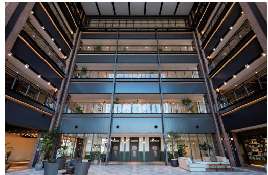
写真11 れんが施工完了(アトリウム全景)
