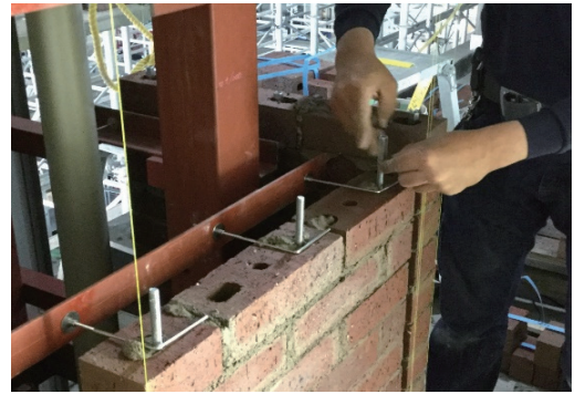
写真9 れんが施工状況
