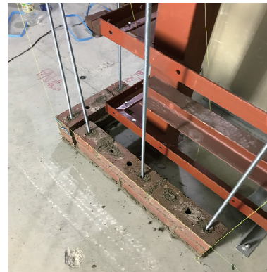
写真10 れんが施工状況
