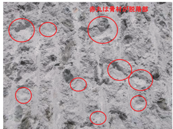
写真4 若材齢コンクリートの切削面
