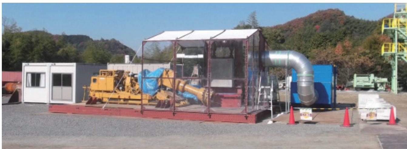
写真 1 切削実証試験装置の配置状況
