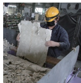
写真5 廃石膏ボード投入状況
