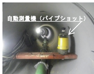
写真 6 管内自動測量
