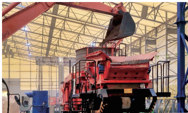
写真10 自走式土質改良機による改質処理
