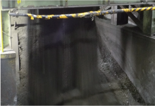
写真 17 改質処理後の処理対象物 (固型化処理施設での破袋時状況)
