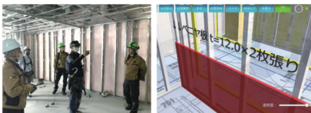
図 13 MR システムによる現場確認状況
