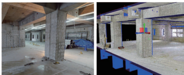
図 11 点群データの重ね合わせ状況
