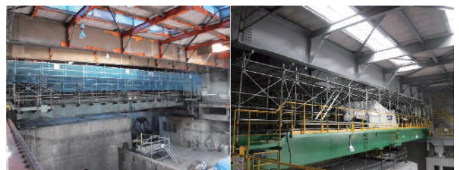
写真12 ごみピット上部鉄骨塗装（洗浄・塗装施工前後）
