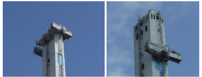
写真 20 煙突リフトの接続状態(左)と単独稼働状態(右)
