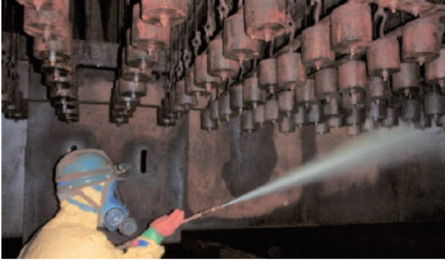
写真4 プラント機器内の高圧洗浄作業
