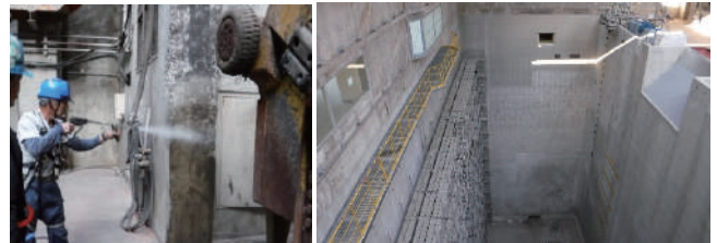
写真10 躯体高圧洗浄状況 写真11 ごみピット全面補修
