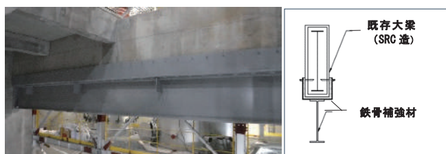
写真13 大梁躯体の鉄骨補強 図9 鉄骨補強材断面図
