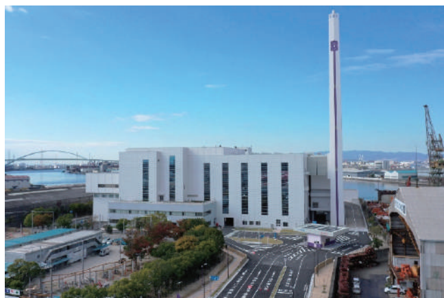
写真 1 更新された住之江工場
