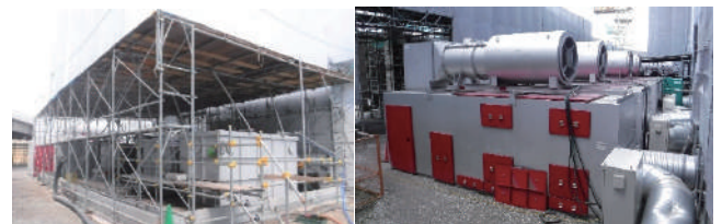
写真2 仮設排水処理設備・負圧集じん器
