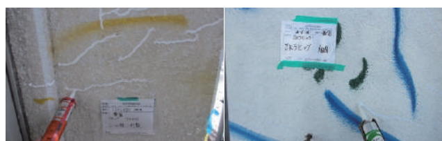
写真16 シール擦込み工法
