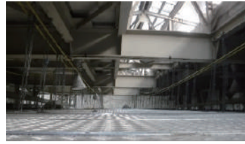
写真9 吊り足場作業床面
