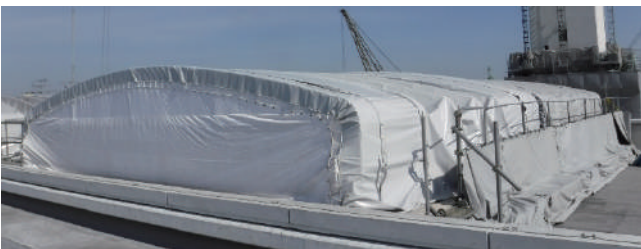
写真5 屋上開口の開閉式テント
