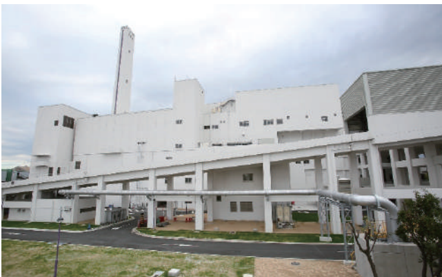
写真 19 ランプウェイ下部躯体の吹付け仕上げ
