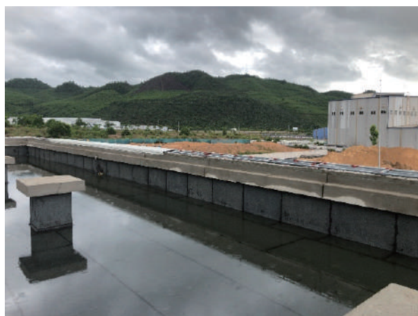
写真7 水張試験でアスファルト防水の水張検査
