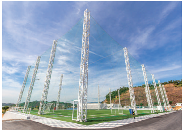
写真10 ドローンテストフィールド
