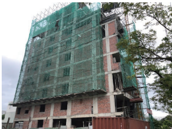
写真 4 ダナンの街中で見た建築途中の建物
