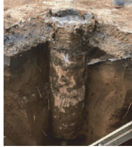
写真3 出来形確認状況（粘性土）
