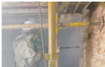
写真6 本除染状況 (レベル3対応保護具着用)
