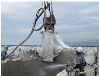
写真 19 外筒解体状況（頂部）
