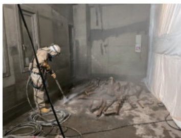
写真8 二次除染状況 (レベル3対応保護具着用)
