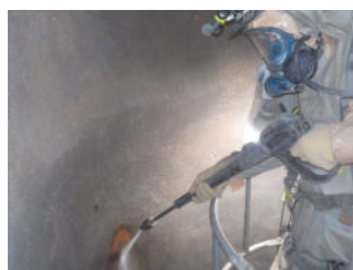
写真14 内筒除染状況
