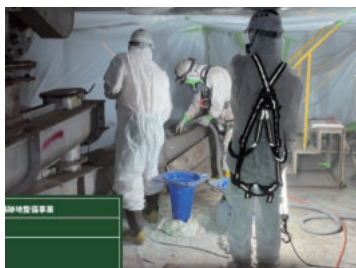
写真5 プレ除染状況
