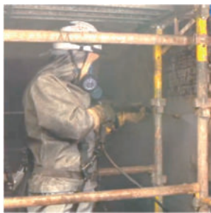
写真2 レベル3対応保護具（プレッシャデマンド形エアラインマスク、スプレー防護用密閉服、化学防護手袋）
