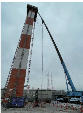
写真 18 外筒解体状況（全景）
