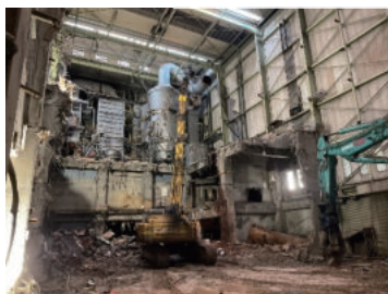
写真7 焼却設備解体状況
