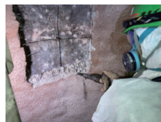
写真15 内筒耐火材研り状況
