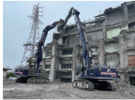
写真12 上屋の解体状況
