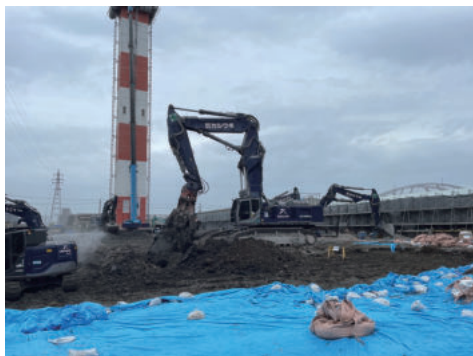
写真13 地下工作物の解体状況
