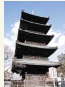
重要文化財の「五重塔」
