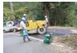
傷みの激しい町道の舗装に協力し、民家入口や農地入口の舗装を行いました
