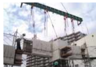
外周PCa梁の取り付け
