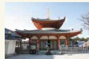
鴻池組が施工した「圓照堂」
