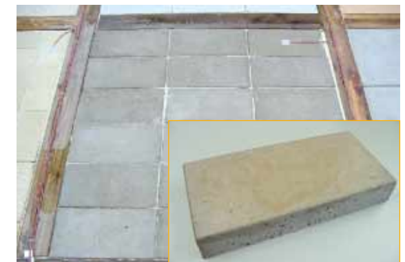
屋上での実験状況とCAPブロック
