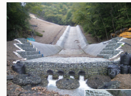
完成した緊急対策工事
