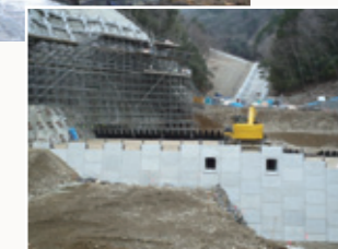
恒久対策工事の状況
