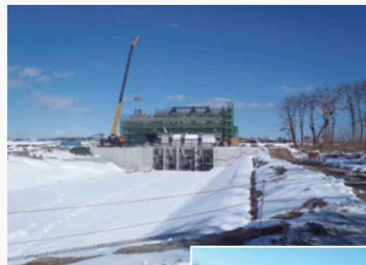
積雪がある中も続く工事
