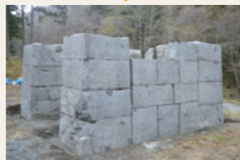
修復完了後(積石は解体し洗浄・補修後、組立)
