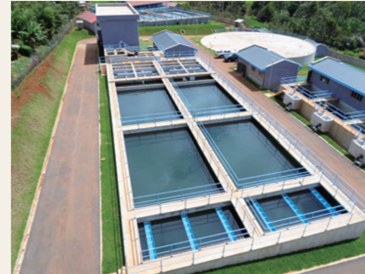
完成した浄水場
