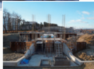
挿門の建設状況
