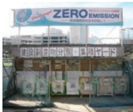
整備された建設副産物分別・集積ヤード (江東区(仮称)シビックセンター新築工事)
