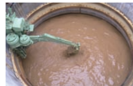
SOCSによる水中掘削施工状況
