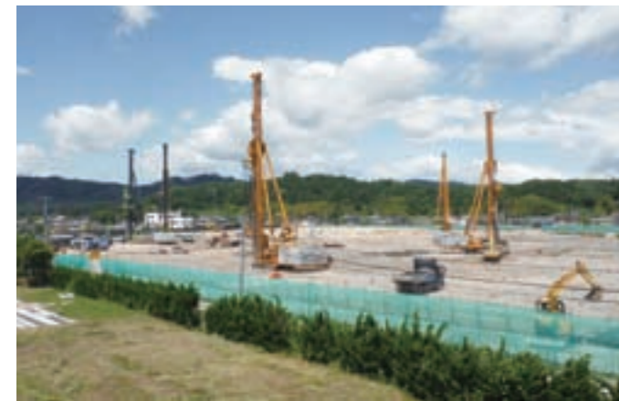
地盤改良施工状況
