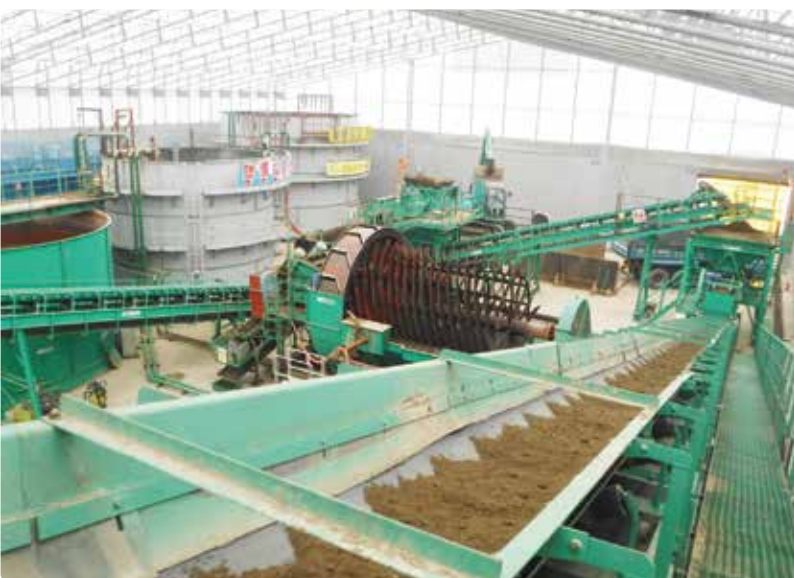
汚染土洗浄状況
