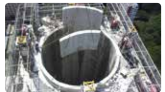
解体した煙突の吊り下ろし作業
