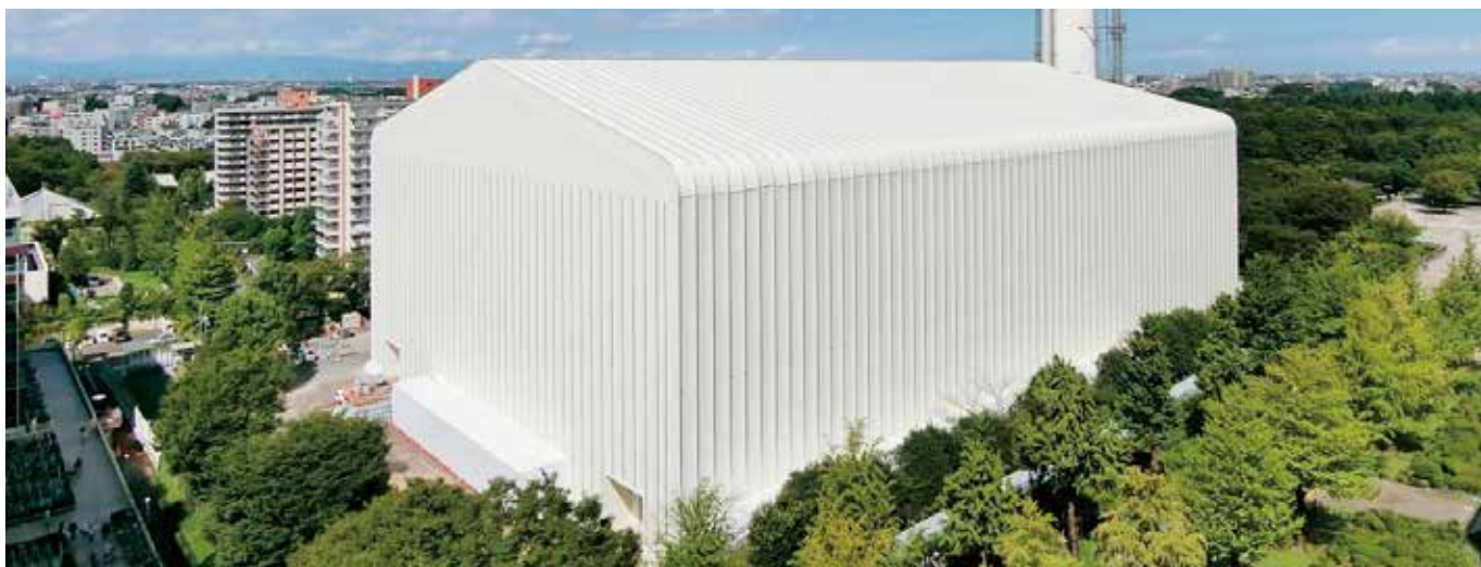
テントで完全に覆われた旧工場
