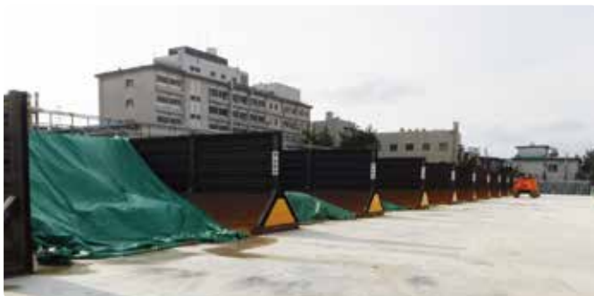
洗浄土仮置場
