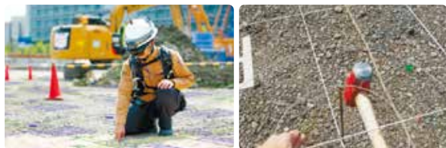
HoloLensによる杭芯出し状況
