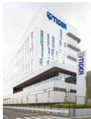
新オフィス棟 外観
