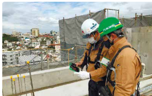
KOCOパトロールを用いた安全パトロール状況
