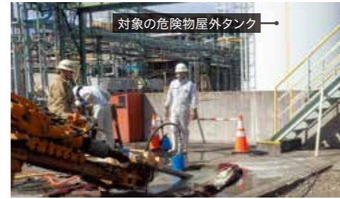
危険物屋外タンク直下の地盤への斜め削孔状況
