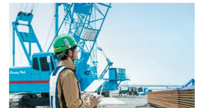
現場の記録写真をドローンで撮影
