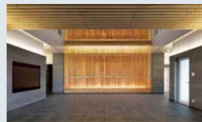
木ルーバーの奥にCLT耐力壁を“現し”で設置
